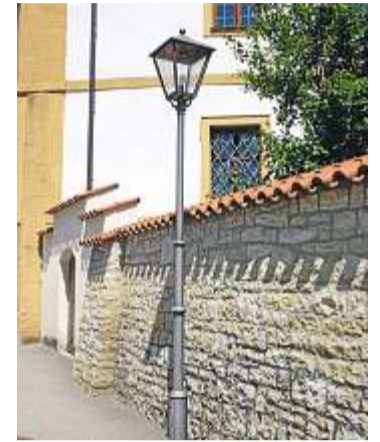
Gepflegtes, grobes Mauerwerk
